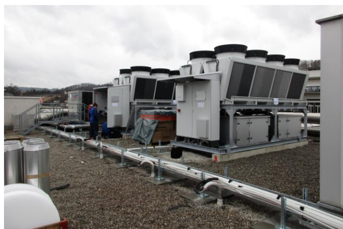
Neue Klimakältemaschinen
