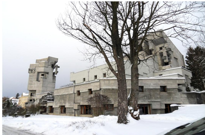
Süd-Ost Ansicht der St. Klemenzkirche
