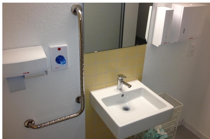
Sanierung sämtlicher Nasszellen der Kirche und des Nebensaals
