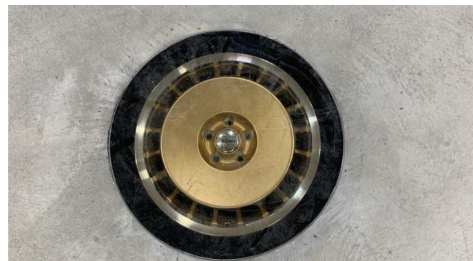
Einbetonierte Alufelge im Eingangsbereich
