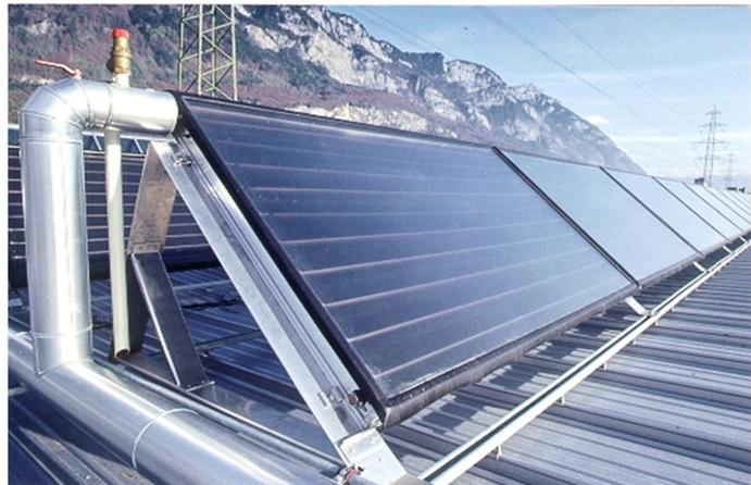
196 m<sup>2</sup> Kollektoren mit 32'000 Liter Speicher für Heizung und Brauchwasser
