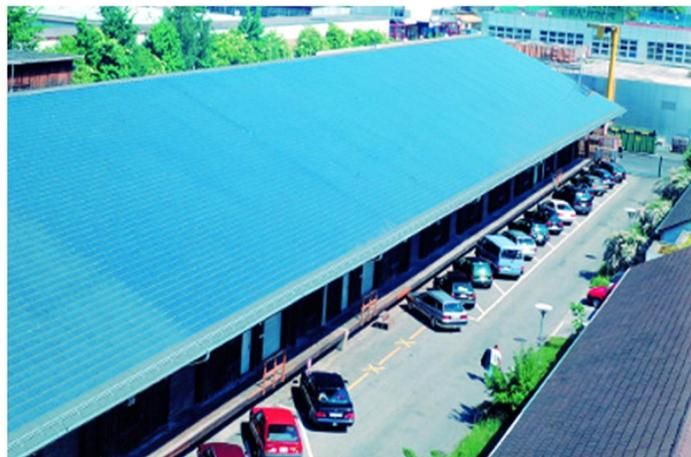
Solarziegeldach mit 6 Zellen pro Schiefer mit einer Leistung von 12 kWp
