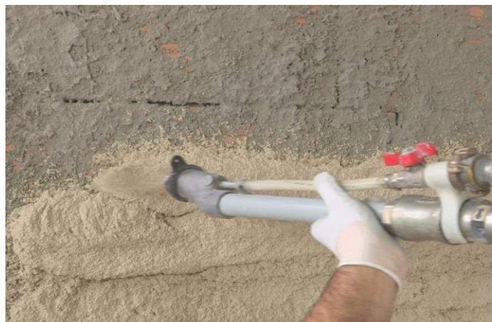
Aerogel – Dämmputz Fixit
