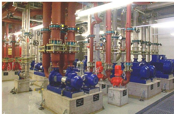
Innenansicht Technikgebäude (Hauptpumpen für Kühlwasserkreise)
