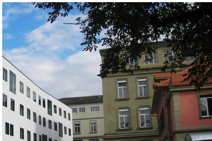
Ansicht West mit Neubau
