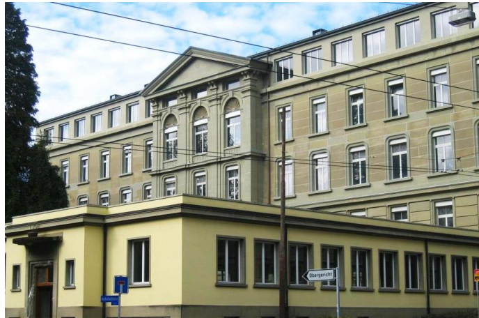
Bestehendes Gebäude (ehemals Frauenspital)
