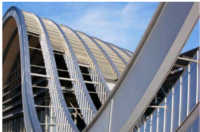
Ansicht Wellendach seitlich
