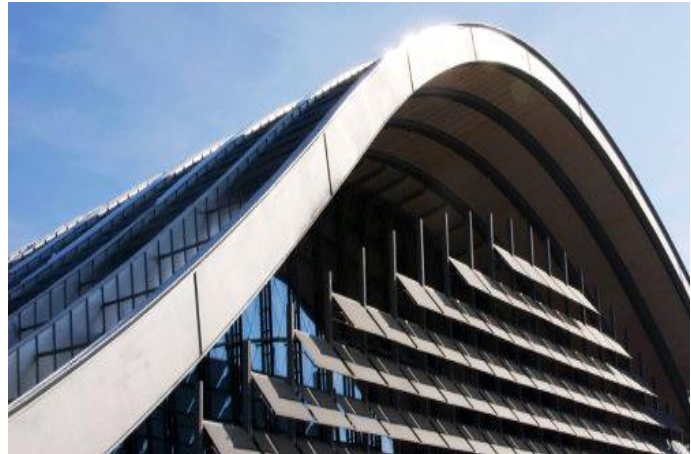
Ansicht Wellendach von vorne
