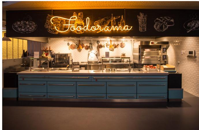
Free Flow Showküche mit Capture Jet Ablufthaube und Objektlöschanlage
