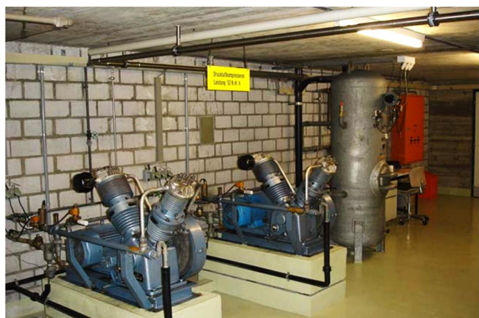
Alte Druckluftanlage
